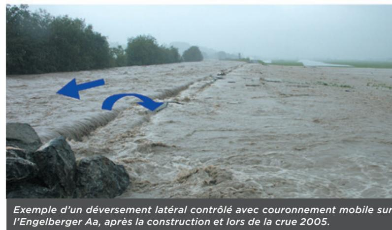
Exemple d'un déversement latéral contrôlé avec couronnement mobile sur l'Engelberger Aa, après la construction et lors de la crue 2005.
